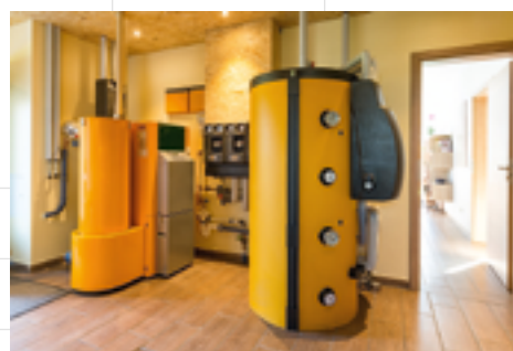
Pelletzentralheizung
